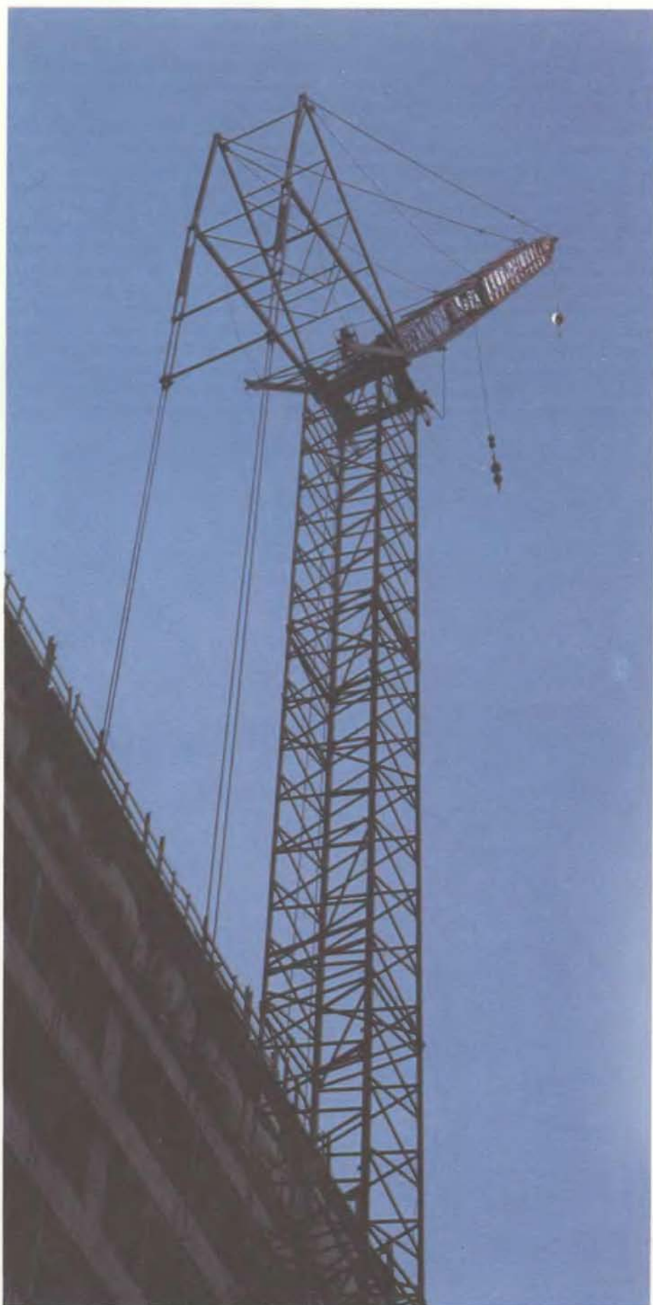
ПОДВИЖНЫЙ ГУСЕНИЧНЫЙ КРАН с башенной стрелой опускает крюк, чтобы взять ковш с бетонной смесью для строительства железобетонного здания. Работы ведутся на 12-м этаже здания, а всего будет возведено 45 этажей.
